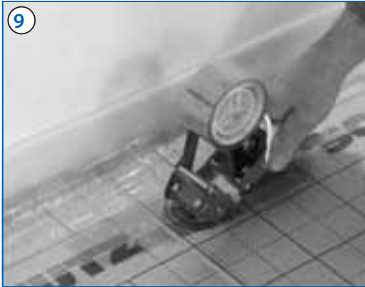
9 Pokud použijeme tekutou mazaninu, musí se dodatečně přilepit foliová zástěrka okrajového dilatačního lemu s přesahem na krycí vrstvu systémové desky u obvodových stěn.
