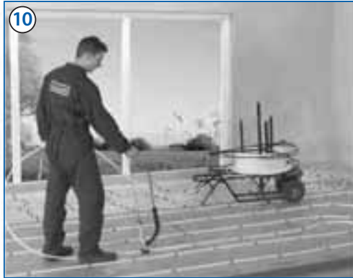
10 Položení otopné trubky začíná na ploše u oken s menšími pokládacími roztečemi (v okrajové zóně).
