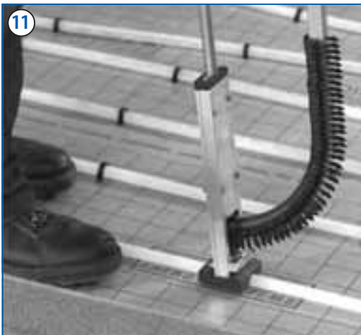
11 S pomocí montážního nástroje Tacker se držáky otopné trubky zatlačí ve vzdálenostech maximálně 50 cm do systémové desky k upevnění trubky.
