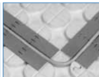
V tepelné izolaci se nacházejí otopné trubky, vložené do teplotrozvodných modulů.
