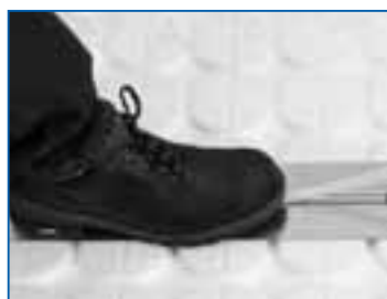
Otopná trubka se jednoduše zatlačí nohou do teplotrozvodných modulů.
